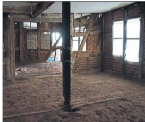
So sieht es im Inneren des historischen Gebäudes aus. Das Haus hat eine lange Geschichte hinter sich - mit vielen Umbauten. Das macht die Arbeiten herausfordernd.
