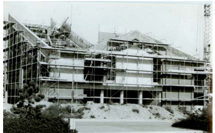
Der Rohbau der Heilig Geist-Kirche
